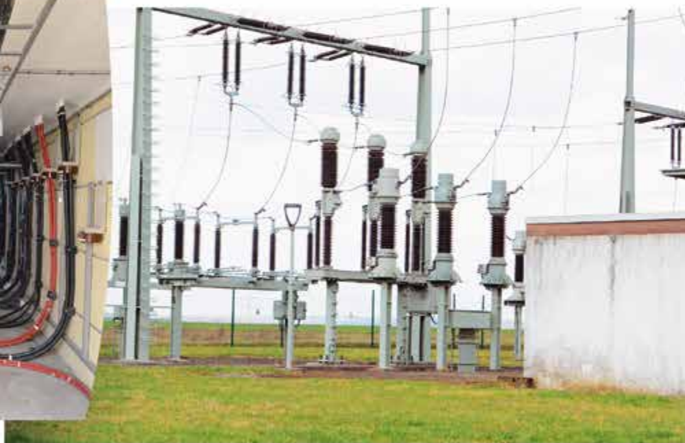
... und oberirdische Neuerungen im Umspannwerk Hungen.
