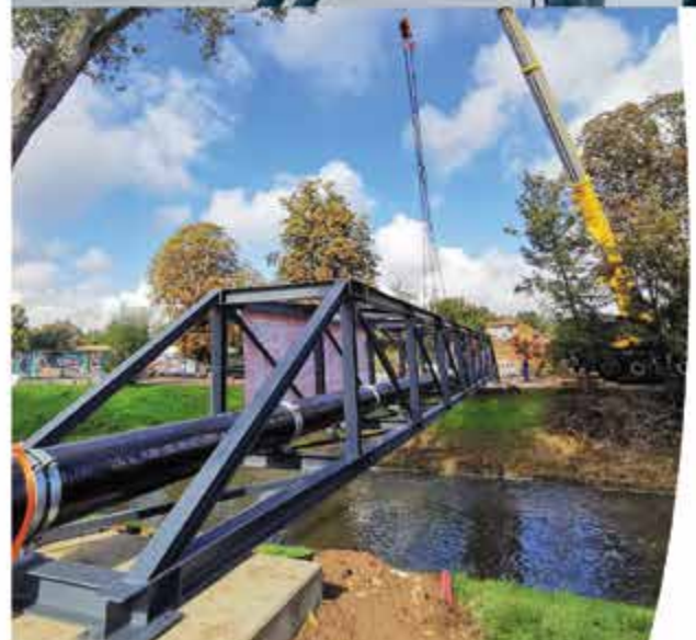
Die neue Rohrbrücke in Bad Vilbel.
