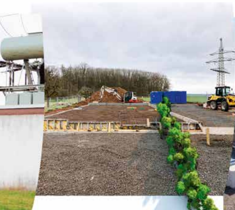
Baggerarbeiten für sichere Stromnetze.
