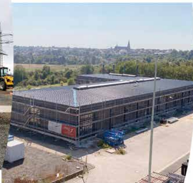
Neubau auf der Warth.
