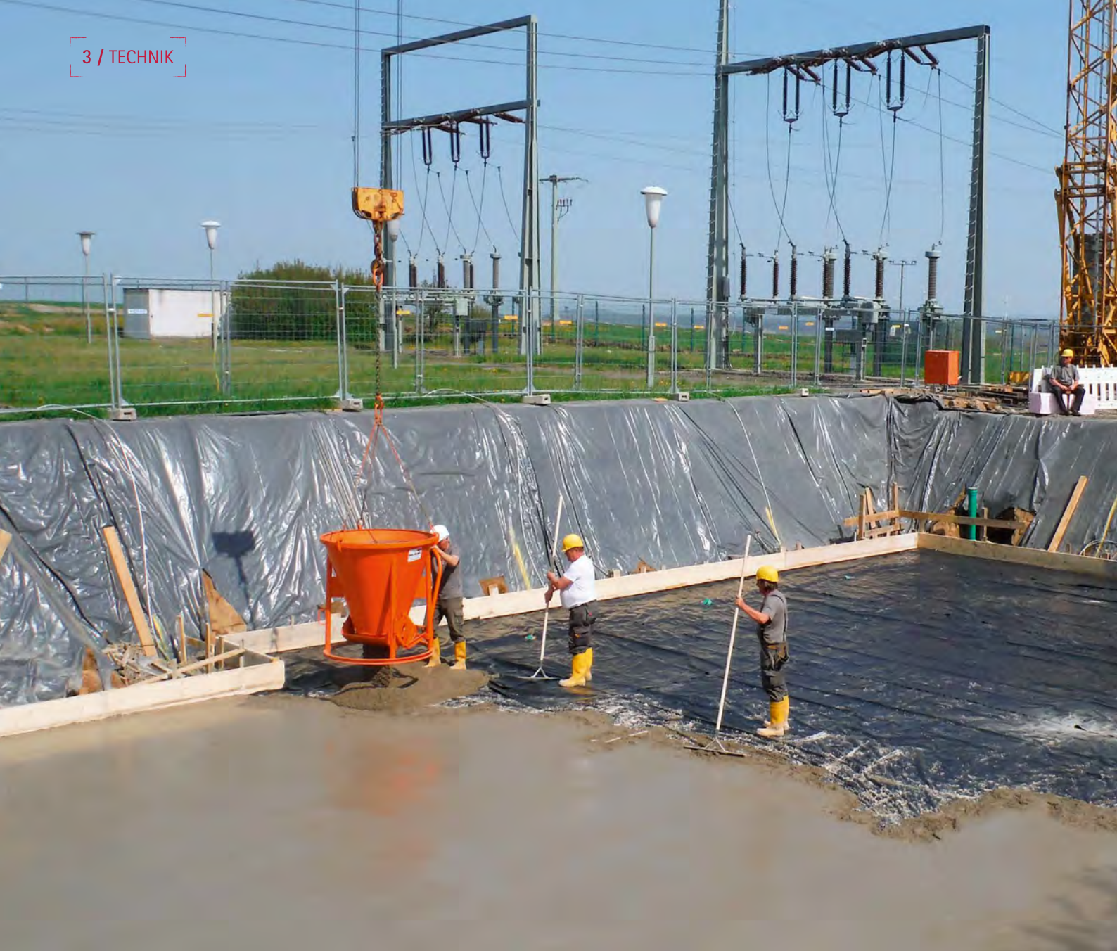
Arbeiten während der Erneuerung des Umspannwerks in Alsfeld.
