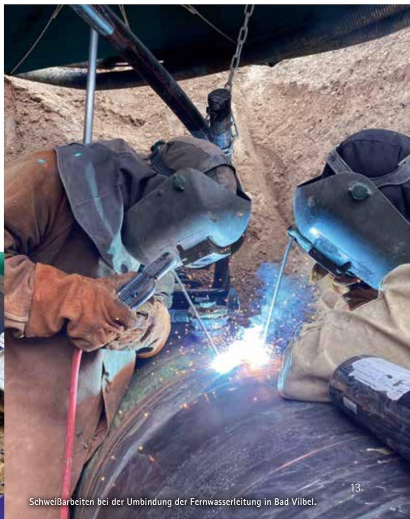
Schweißerarbeiten bei der Umbindung der Fernwasserleitung in Bad Vilbel.
