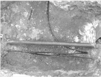
Freigelegte Hauptversorgungsleitung 0,4 kV (zur späteren Montage des Netzanschlusskabels). Hier ist auch die Telefonleitung (dünnes Kabel) gut sichtbar.
