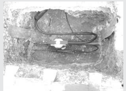
Hausanschlussmuffe nach der Endmontage. Die Isolationsmasse schützt die Abzweigklemme vor Feuchtigkeit.
