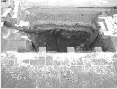
Muffengrube im Gehwegbereich
