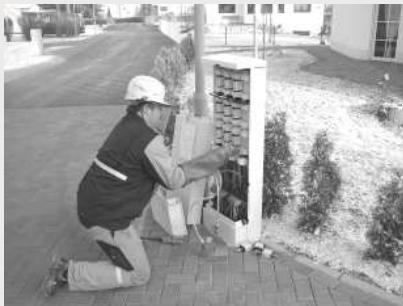
Freischaltung der Hauptversorgungsleitung 0,4 kV (hier entfernt der ovag Netz GmbH -Monteur die Sicherungen im Kabelverteilerschrank).
