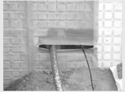
Einführung des PE Rohres durch die Hauswand. Eigenleistung des Hauseigentümers
