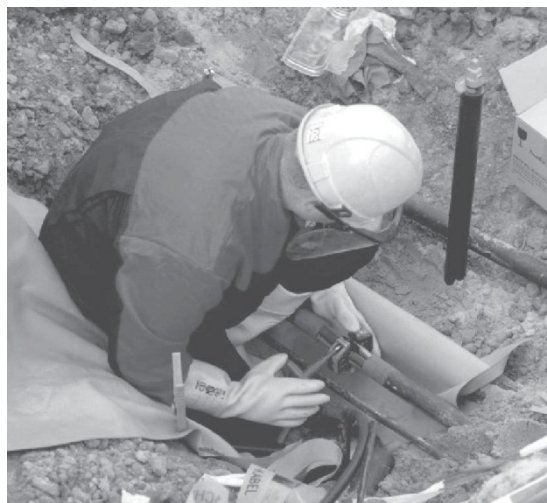
Mitarbeiter bei der Montage eines Netzanschlusses.
