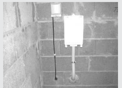
Montierter Hausanschlusskasten
